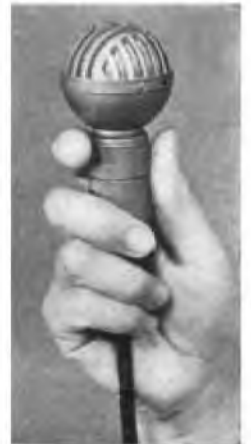
Bild 1. Kleiner als ein Tennisball ist das neue Kristall-Kugelmikrophon. Es ist bequem in der Hand zu halten, von allen Seiten für die Besprechung gleich empfindlich und sowohl für Musik- wie Sprachübertragung gut geeignet.
