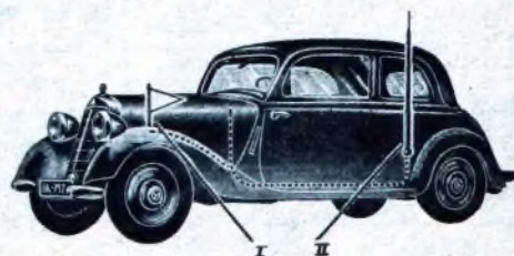
Die Telekopantenne, zusammengeklappt (I) und ausgezogen (II).
