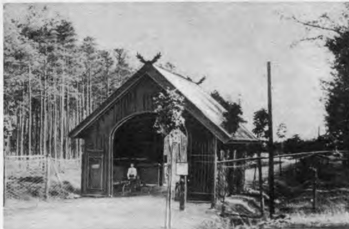
Quer durch den Torbogen dieses unscheinbar anmutenden Häuschens läuft der unsichtbare Lichtstrahl, der bei Unterbrechung, z. B. durch Wild, Signale auslöst. Aufn. AEG.
