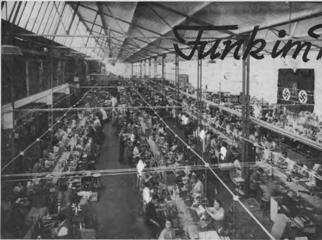
So sieht's in einer modernen Rundfunkempfängerfabrik aus, wenn Hochbetrieb herrscht. Drei Fabrikationsbänder laufen der Länge nach durch die Halle, zu beiden Seiten sitzen die Arbeiter und Arbeiterinnen, um ihre Handgriffe an dem vorbeiziehenden Stück auszuführen. Werkphoto Lorenz.
