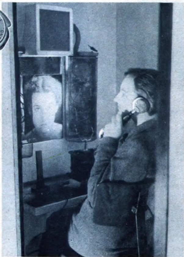
Beim Fernsprechen seinen Gesprächspartner sehen - der Zukunftsraum, hier schon verwirklicht. Die Deutsche Reichspost zeigte eine Station für „Gegen-Fernseh-Sprechen“. (Reichspostminist., Bildstelle)
