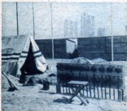
In freiem Feld, auf einem Brett montiert, die zahlreichen Lautsprecheranschlüsse, von denen es einerseits zum Regiewagen, andererseits zu den Lautsprechergruppen geht.
