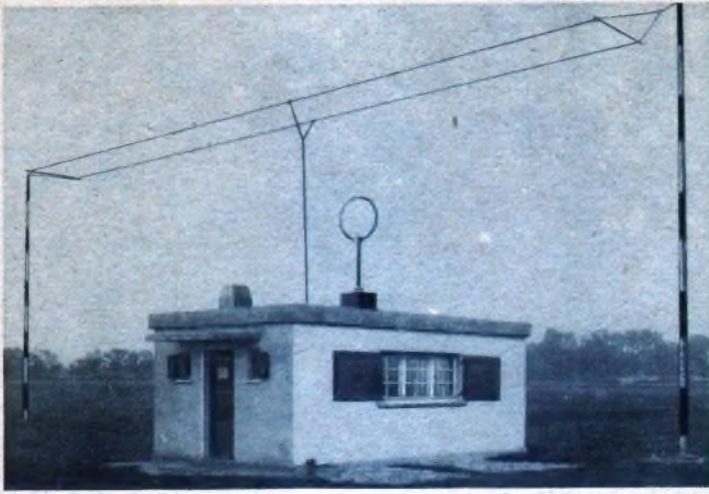
Eine sog. Bodenfunkpeilstelle, wie man sie heute regelmäßig auf Flugplätzen findet. Wieder erkennen wir den Peilrahmen, der vom Innern aus bedient wird.
