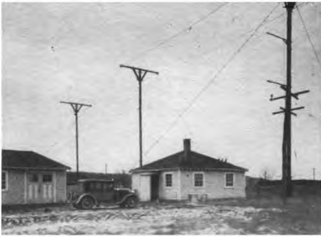
Diese merkwürdig geformte Antenne in Schenectady zwingt die drahtlosen Wellen in die Richtung nach Deutschland.
