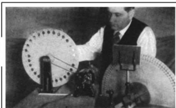
Der neue Fernsehsender hat eine ausnehmend große Nipkow-Scheibe mit Linsen.
