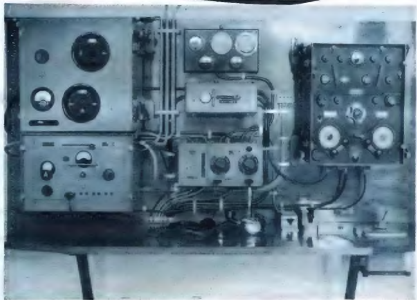
Dieses Bild zeigt die moderne Funkstation des Überses-Flugbootes Do X1
