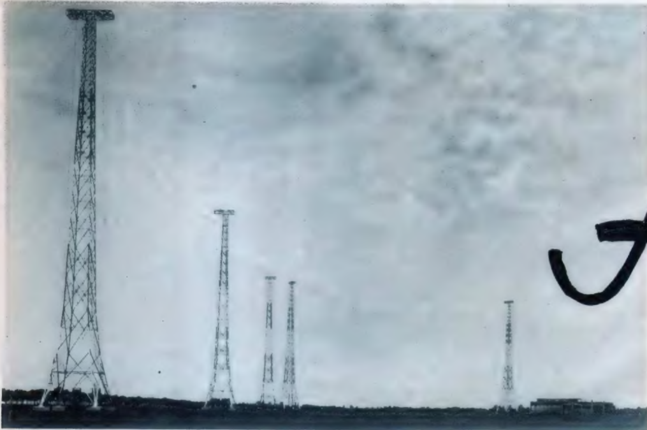
Riesigen Spinnennetzen gleich ragen die neuen Richtantennen von Nauen in den Himmel hinein.
