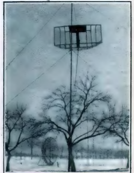
So sieht ein Detektorempfänger für 40-cm-Wellen aus.
