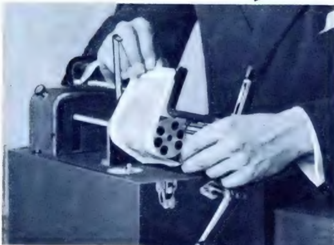
Zur probeweisen Eröff- nung des Bildfunks nach dem System Foulton in Deutschland: Das fertige Bild wird von der Walze abgenommen.
