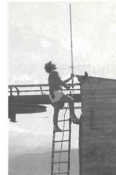
Le fasi dell'installazione dell'antenna.
