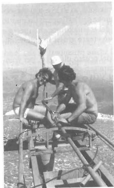
Il montaggio del generatore eolico a 1840 metri.
