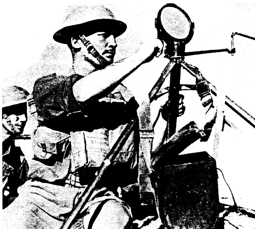
Fig.14. Heliograaf in actie bij het beleg van Sollum in 1941 tijdens de oorlog in de woestijn van Noord-Afrika.
