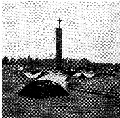
De TV-zendmast in Oldenburg in aanbouw. (8 October 1955) (foto PAoVT)
