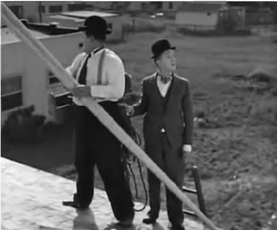
"Radiomanía" (1930). Para tomar nota de lo que NO hay que hacer cuando se intenta montar una antena en el tejado
