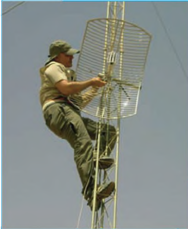
Foto F. La torreta existente fue de utilidad para mejorar el alcance del enlace WiFi. EA5XQ, en una incómoda postura, ajustando la antena.
