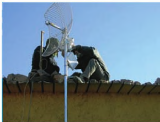
Foto D. EA5XQ, montando la antena en la azotea del edificio de la Presidencia.
