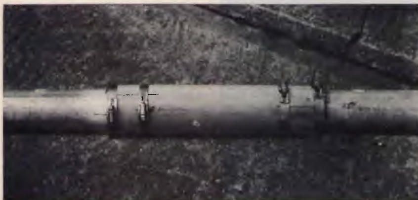
foto 2 La giunzione tra i due spezzoni di tubo.
