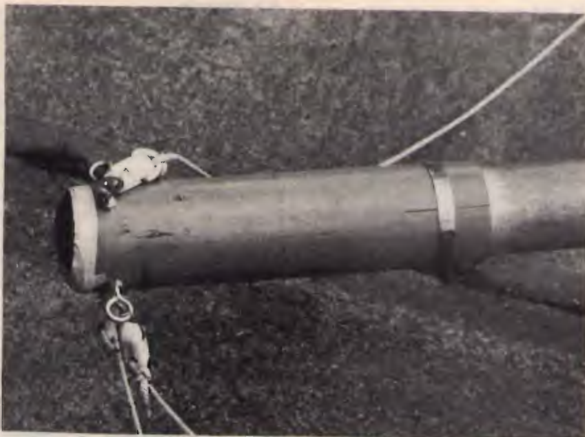
foto 5 La calotta protettiva fissata alle controventature.
