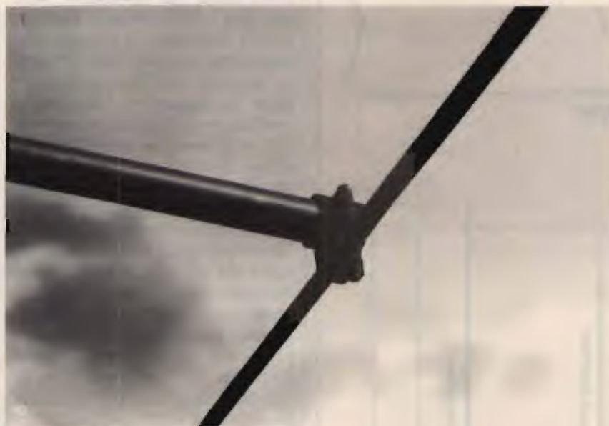
foto 3 Particolare del prototipo per ancoraggio elementi con raccordo a 90 gradi (kit SIRTEL).
