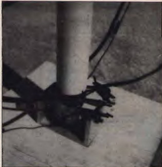
figura 6 La base del palo con la staffa a U.
