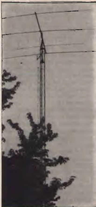
foto 3 Le antenne di N8BJQ.
