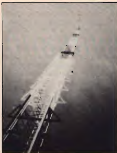
Una delle torri di sostegno per l'antenna di WWVB/WWVL; l'altezza è di 122 metri.
