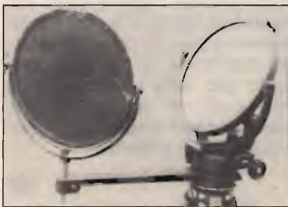
foto 4 L'eliografo canadese Mark V, usato fino al 1941 dall'esercito canadese. La modulazione si otteneva tramite spostamenti dello specchio; la portata poteva facilmente raggiungere i 40 chilometri.
