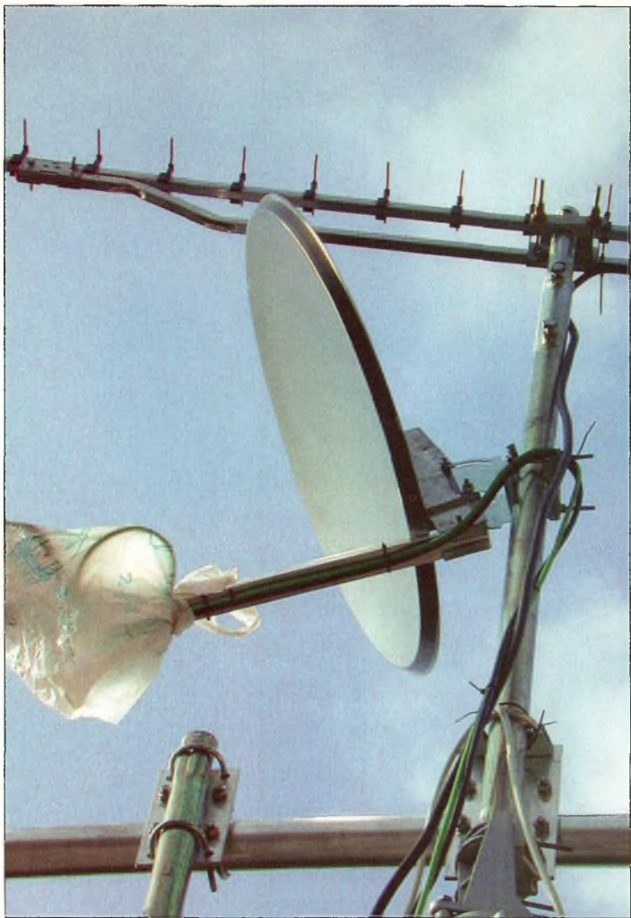
Une autre possibilité de réglage de l'élévation d'une offset de 60 cm.
