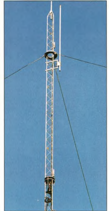
Photo 6- La partie tournante du pylône de l'auteur.
