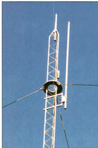
Photo 5- La partie supérieure du pylône.
