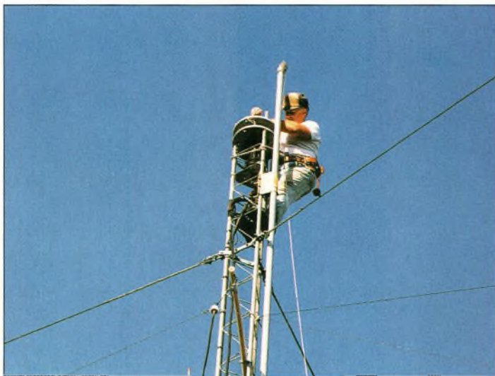
Photo 2- L'auteur fixe le roulement à 20 m du sol.
