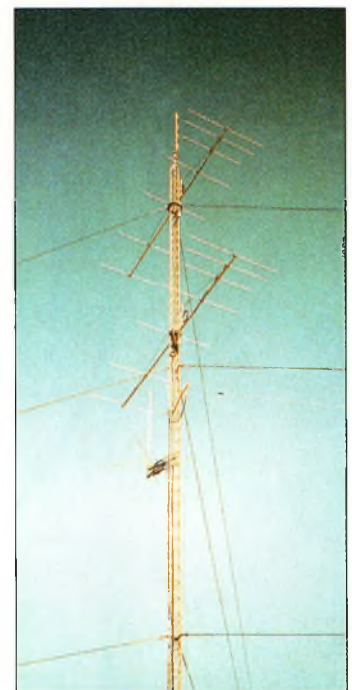
Photo 7- Les travaux sont terminés.
