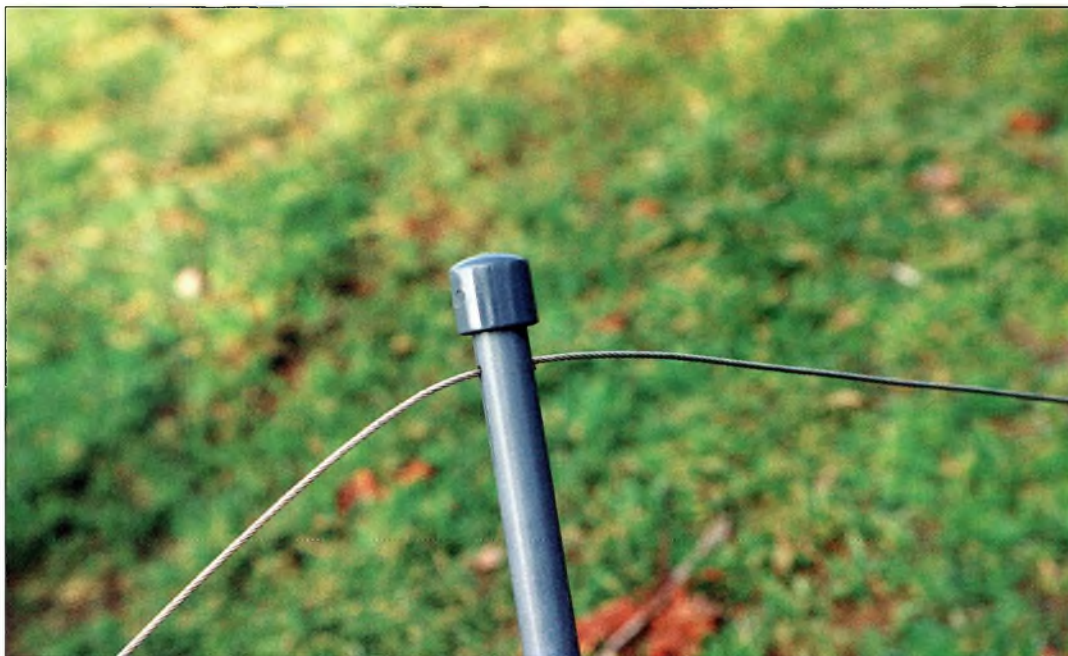
Gros plan sur la fixation des écarteurs au fil d'antenne.
