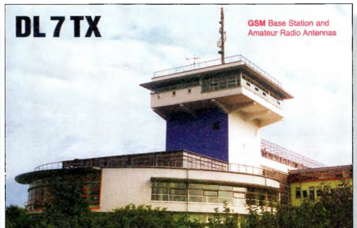
Des antennes GSM qui côtoient une beam et des filaires radioamateurs.
