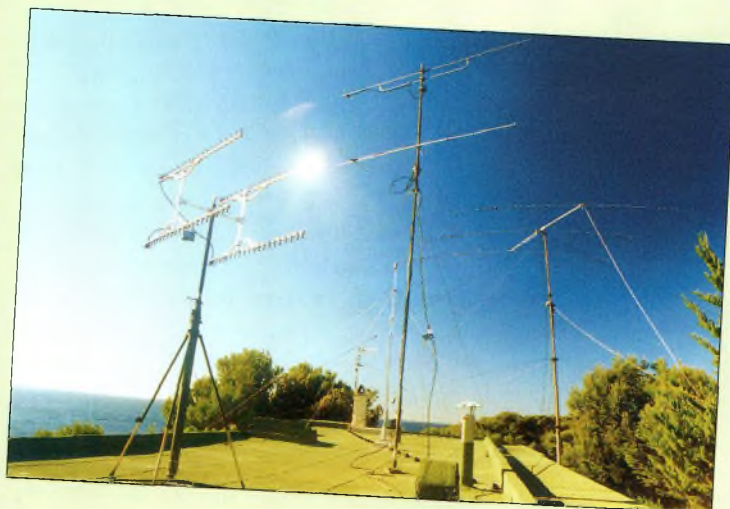
A gauche, le groupement SHF, au centre, les antennes VHF et UHF, à droite, la TH3 pour les bandes 14, 21 et 28 MHz.
