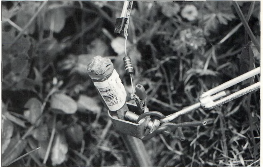
Côté opposé avec la résistance de 470 ohms et le piquet de terre.
