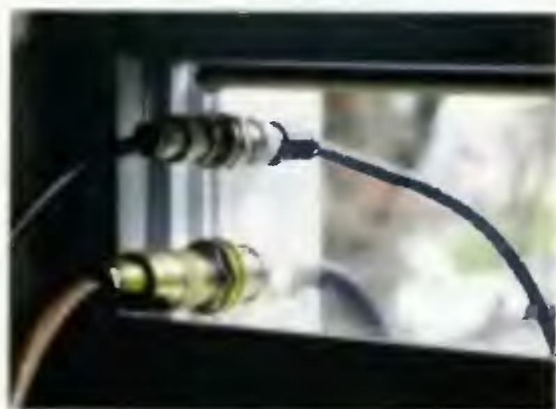
Obr. 30. Instalace průchodek („bulkhead“ SO-239 a BNC) ve sklepním okénku
