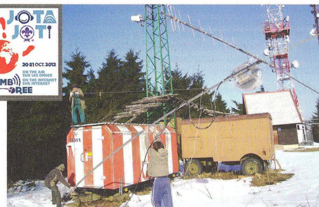
Obr. 2. Skauti z RK OK1RSJ stavějí anténu na Suchém vrchu, lokátor JO80IB (995 m n. m., rovněž QTH FM převáděče OK0F v pásmu 145 MHz). Yagi je typu F9FT pro pásmo 70 cm, SBF (Short Backfire Ant.) pro pásmo 23 cm. Na střeše buňky je Mirek, OK1UVU, dole roveří Dominik a Dan
