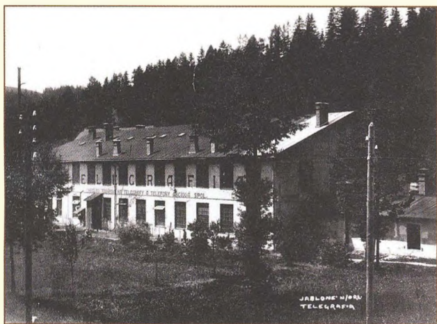
Obr. 1. Budova Telegrafia a. s. v Jablonném nad Orlicí
