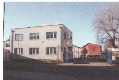
Výrobní budova firmy Tronic
