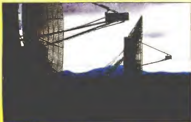
Obr. 4. Instalace systému R-408
