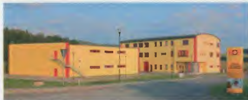
Nové sídlo firmy ELEKTROBOCK
