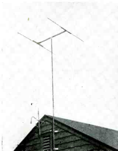
Fig. 4—Di-pole and reflector
