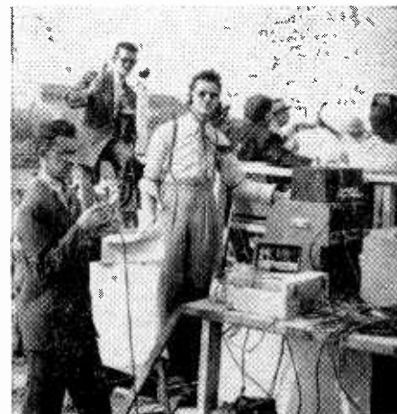
L'équipe technique de CKRS, lors de la radiodiffusion de la bénédiction et de l'inauguration officielle du pont d'Arvida, le 16 juillet dernier: Paul Fortin, Paul-H. Bouchard et le chef du service des nouvelles. A l'arrière-plan, une partie du nouveau pont et des barrages de Shipshaw.
