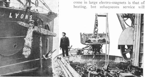
THE OLD WAY OF RAISING IRON FROM THE DEEP COMPARED WITH THE MODERN LIFTING MAGNET
