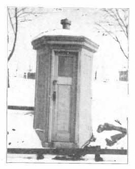
CAST CONCRETE TELEPHONE HOUSE USED IN A RAILROAD BLOCK SIGNAL SYSTEM
