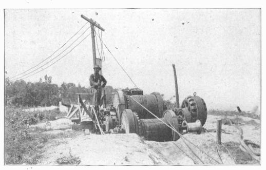
UTILIZING THE ELECTRIC HOIST TO DRAW A SCRAPER
