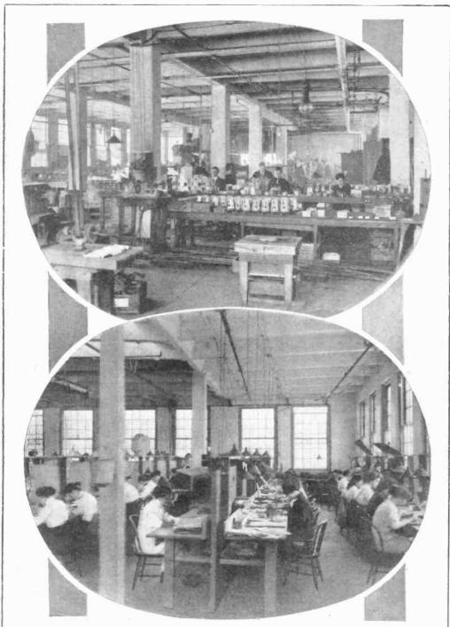
THE UPPER ILLUSTRATION SHOWS ONE OF THE ASSEMBLING ROOMS WHERE THE ELECTRIC COOKING UTENSILS BEGIN TO TAKE DEFINITE FORM. BELOW IS SHOWN THE PROCESS OF WINDING AND FORMING THE HEATING UNITS
