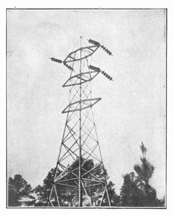
100,000 VOLT TRANSMISSION LINE STRAIN TOWER
