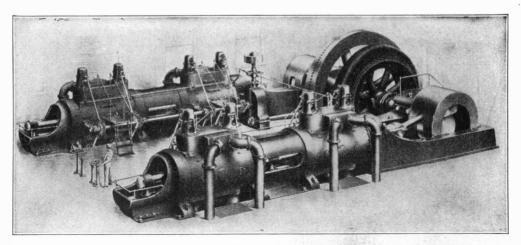
A TYPE OF MODERN GAS ENGINE FOR DRIVING ELECTRIC GENERATORS-CAPACITY 2500 HORSEPOWER s
