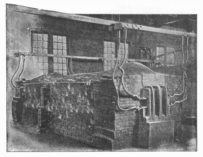
CARBORUNDUM FURNACE DURING OPERATION
