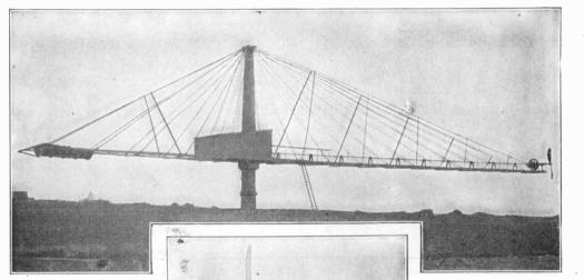
SWINGING CANTILEVER FOR TESTING
