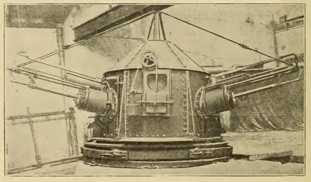
FIG. 2. STASSANO FURNACE IN OPERATION.
