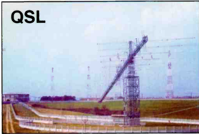
Antennas at the Vatican Radio Santa Maria di Galeria site.
