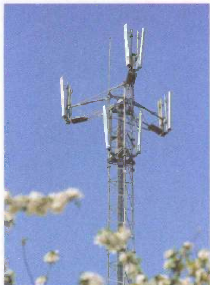
Un relais à trois secteurs, dont il est fort instructif de faire le tour, mode "trace" du GSM activé.
