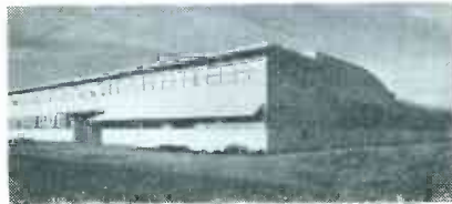
New Kaar plant
