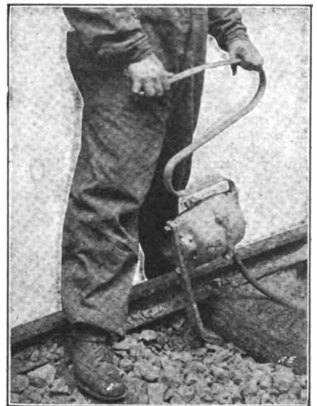
Electric Tie Tamper in Actual Use.
