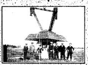
INSULATED MAST FOUNDATION ON THE GERMAN TYPE MAST
