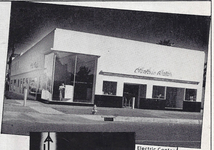
Electric Center Phoenix, Ariz.
