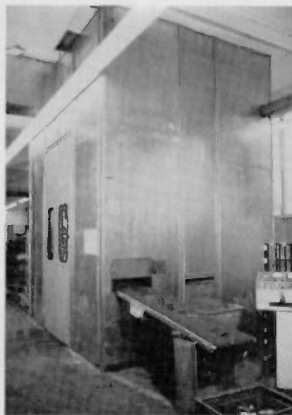
Bild 7 Materialauslauf an der Spezial-Kapselung
