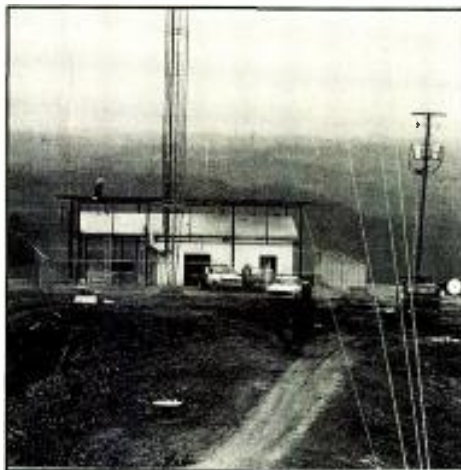
WYMT-TV transmitter site
